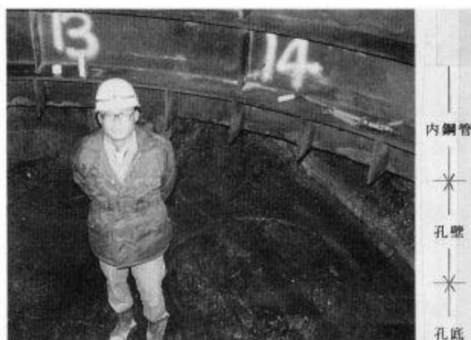
▲写真-1 大鳴門橋4Pの底面にて(1978年12月)
